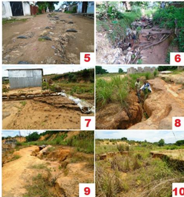
Photo 5 : dispositif en pneus usés des décapages superficiels d'une ruelle à Mansimou ; photo 6 : ravinement et déchaussement des racines d'un arbre sur une ruelle ; photo 7 : rigole et lutte antiérosive par des digues en sacs rempli de terre, autour d'un habitat à Mayanga ; photos 8, 9 et 10 : ravines dans une dépression et une ancienne carrière de sables à Mayanga ;
