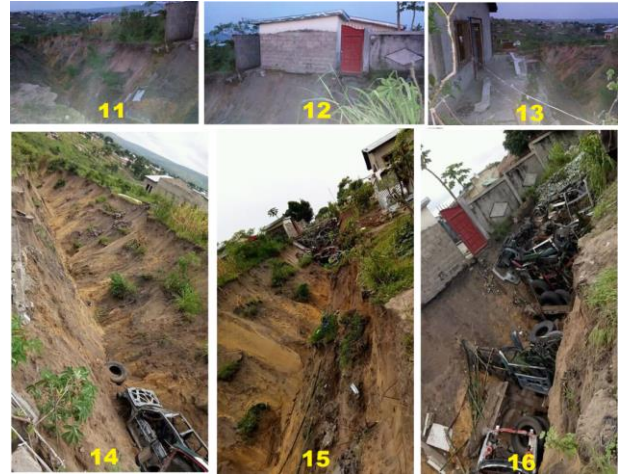
Photos 11, 12, 13, 14, 15 et 16 : ravinement régressif affectant les une ruelle à Mayanga. Sur les photos 15 et 16 on voit une méthode curative de lutte contre le ravinement : pneus usés et carcasse de voiture
